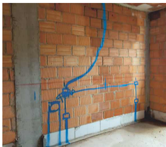
Classico esempio di parete in laterizio soggetta a tracce per impianti
